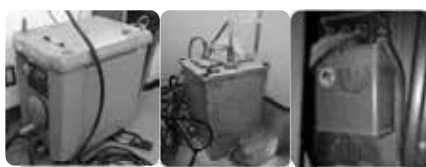
電気溶接機 X線発生装置 配電盤
