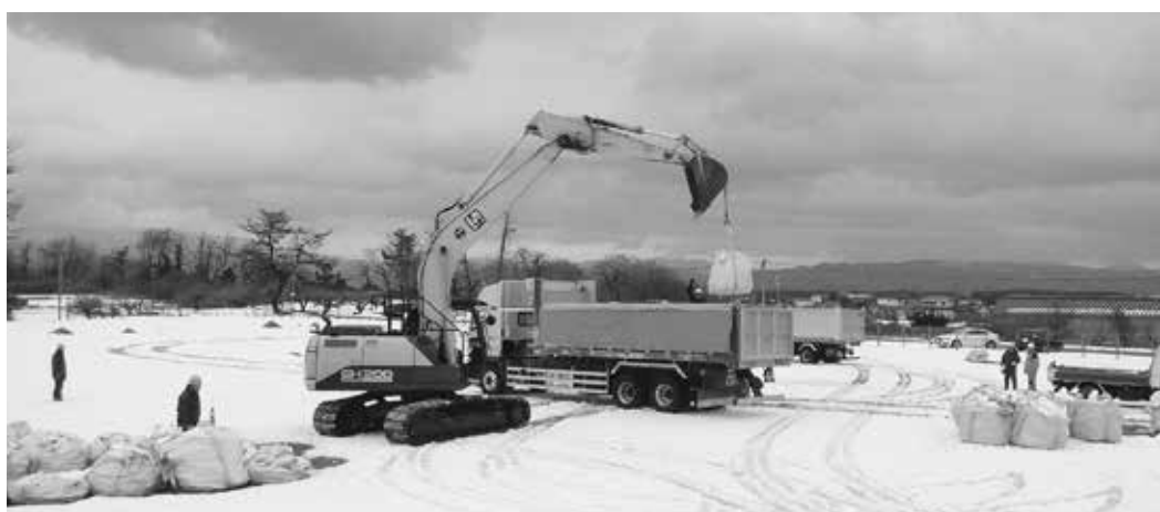
R 7. 1. 14 積雪期となった最終搬出作業 （酒田市仮置場／旧酒田工業高校跡地）
